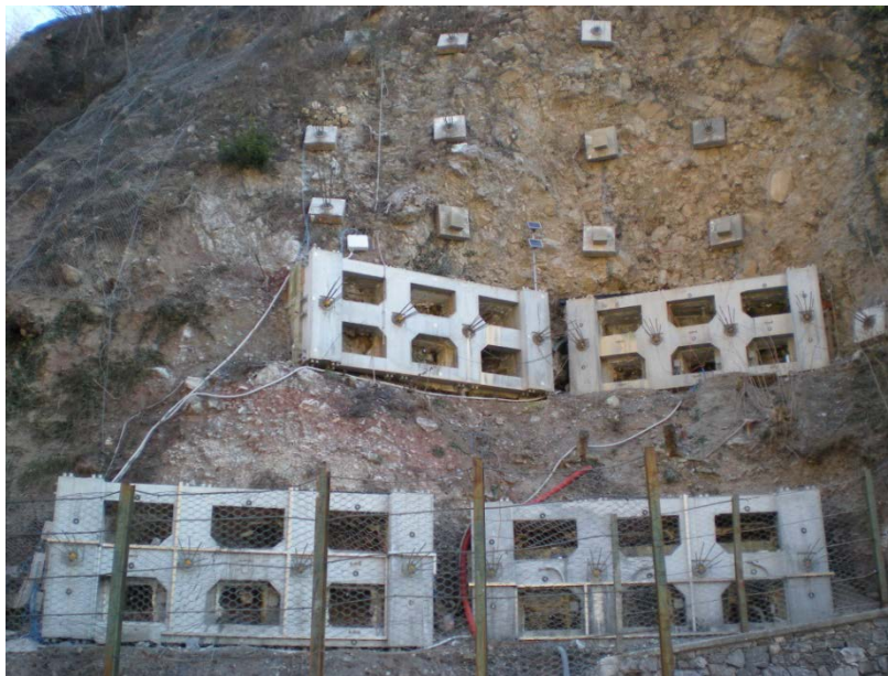
Figura 1-6 – Caslino d’Erba (CO), Italia, (2008) Graticci e piastre di ancoraggio realizzate in calcestruzzo autocompattante fibrorinforzato per la stabilizzazione attiva di pendii. Calcestruzzo C60–S5–12–XC4–F4–DH1–DS1 (UNI11039).
