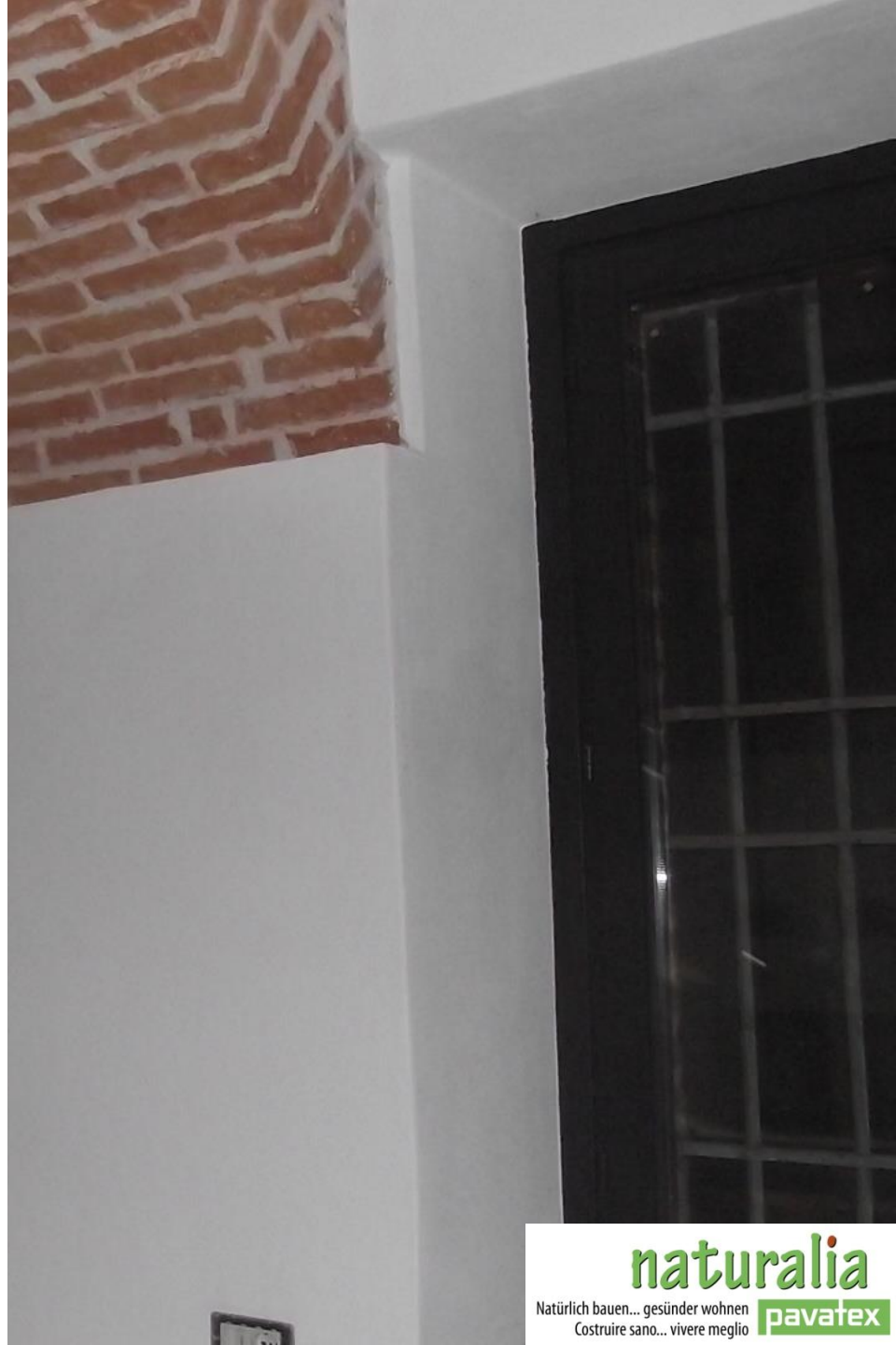
Arch. Zen, impresa Razzetti, cantiere in Santena Torino
