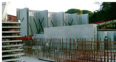
E' un serbatoio interrato della capacità di 30.000 mc, realizzato mediante un'innovativa tecnologia che utilizza bilastre prefabbricate.
