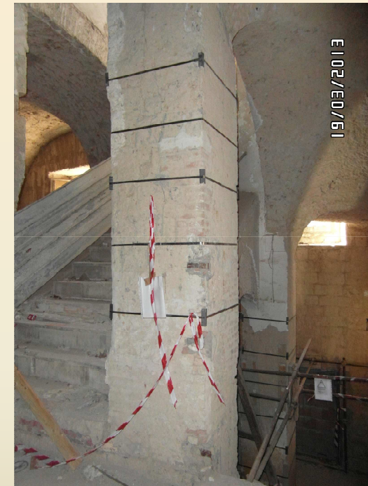
Intervento provvisorio di cerchiatura di pilastro in muratura con reggette in acciaio inox
