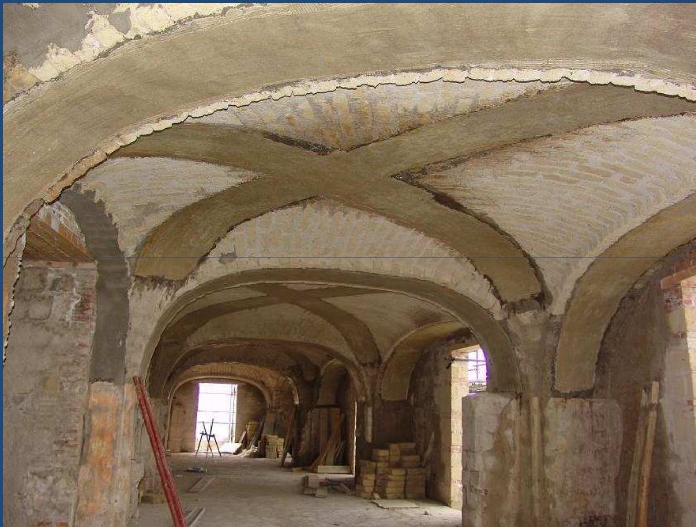
Placcaggio intradossale di volte a crociera
