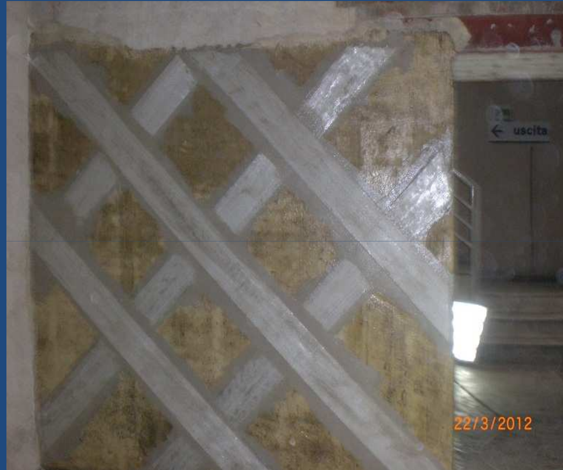
Placcaggio per rinforzo a taglio di un setto in muratura
