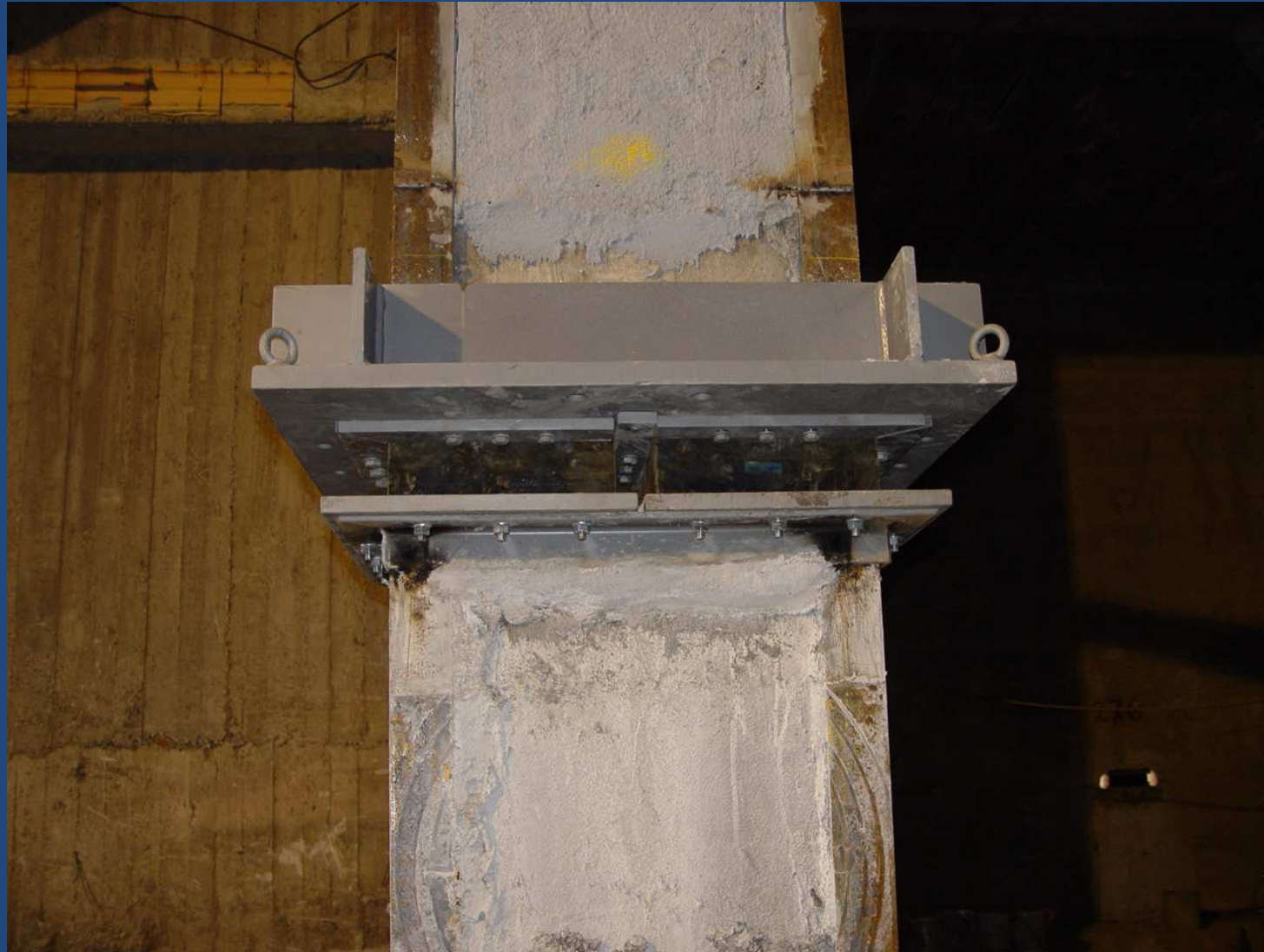
Dettaglio delle piastre di collegamento. Centro Polifunzionale di Napoli.
