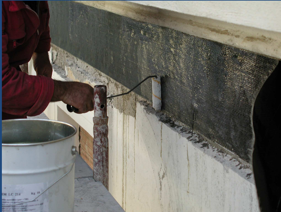
Polimerizzazione con rullo di fasce in tessuto di carbonio
