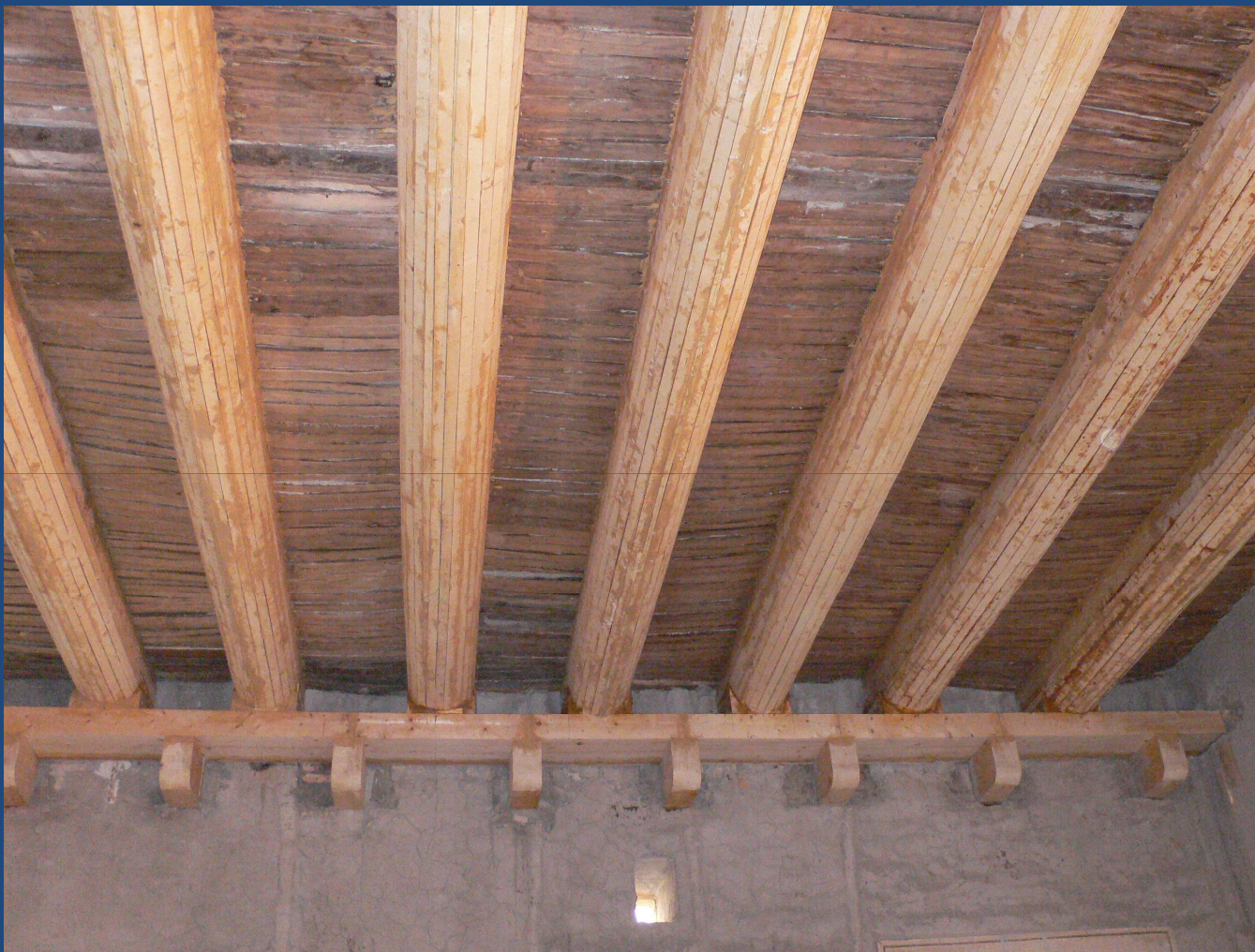
Il solaio in legno completamente restaurato
