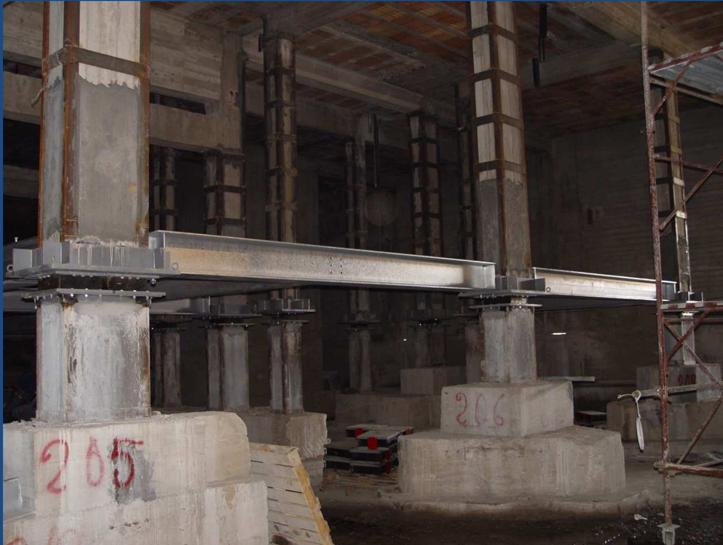
Dettaglio dell'impalcato rigido al di sopra del piano di isolamento. Centro Polifunzionale di Napoli.
