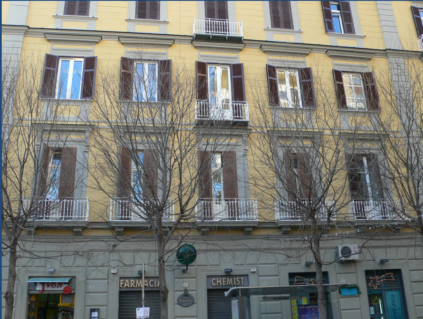
Vista di una facciata con pannelli con larghezza insufficiente
