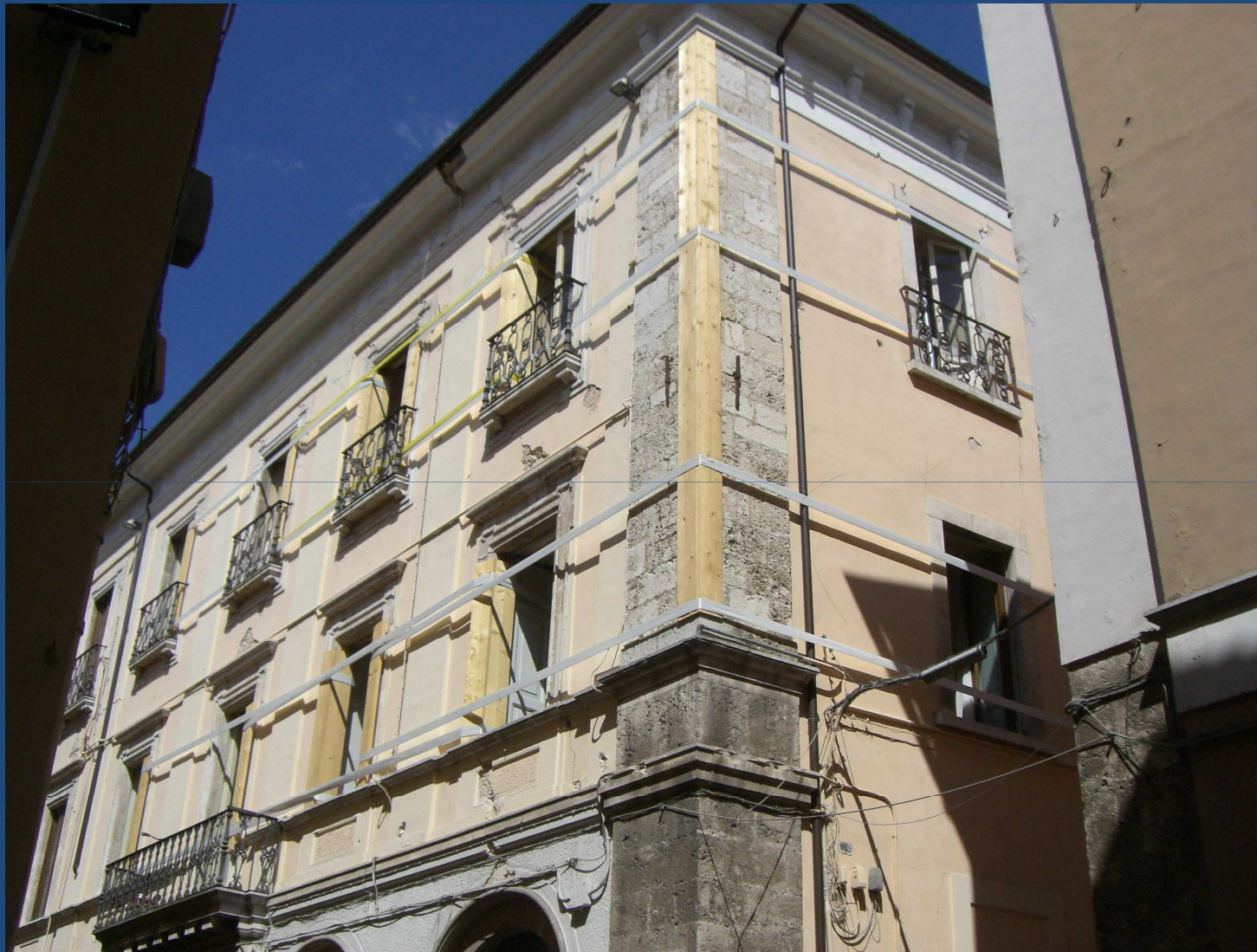
Intervento provvisorio posto in atto a L'Aquila nell'immediato post terremoto
