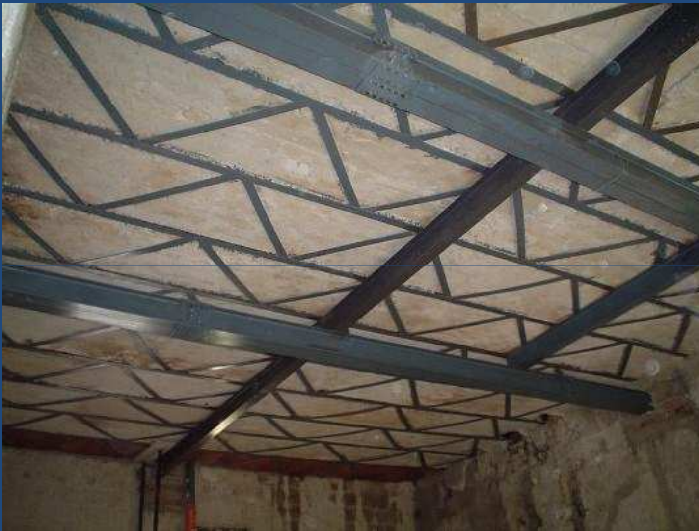
L'intervento di rinforzo completato
