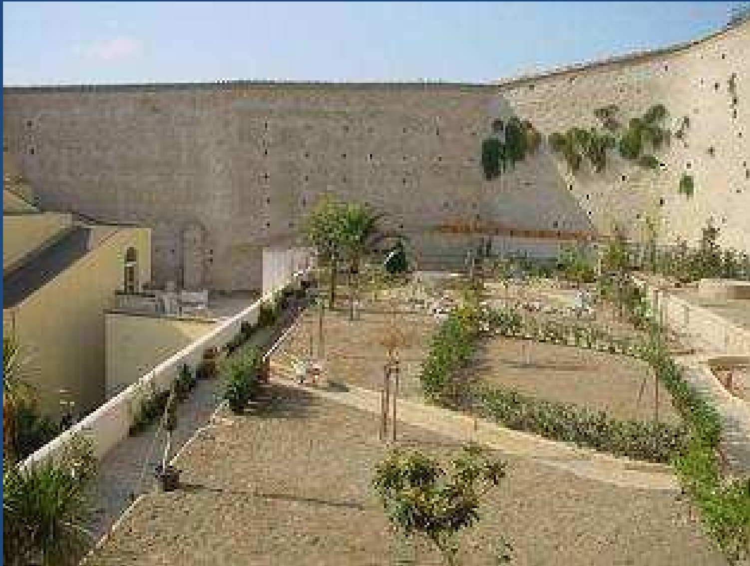
Le mura ad intervento completato
