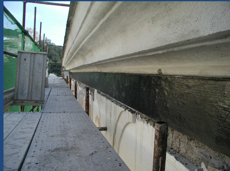
Applicazione di fasce a quota cordolo di un fabbricato in muratura
