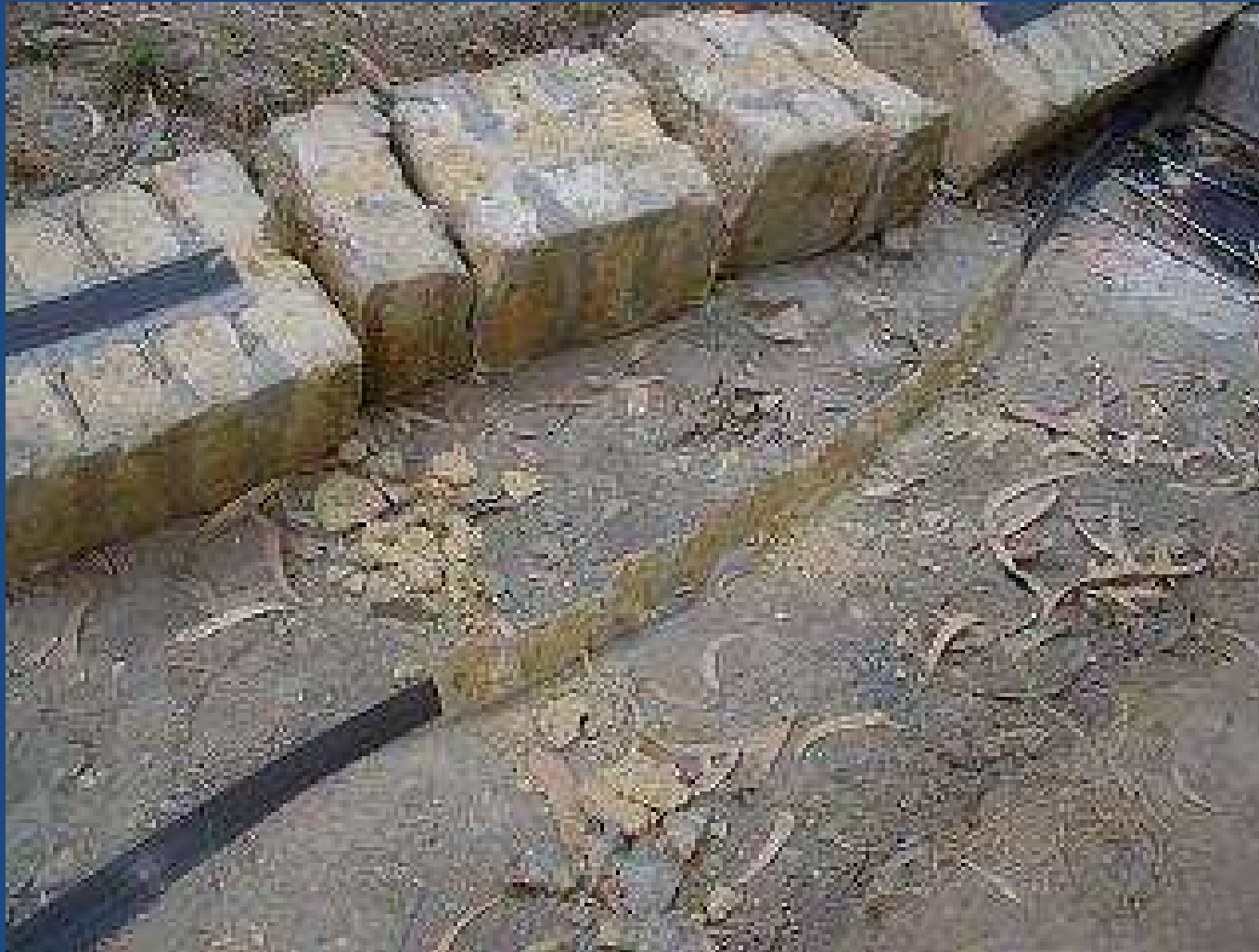
Collasso con distacco del tessuto per scorrimento e trasporto del tufo
