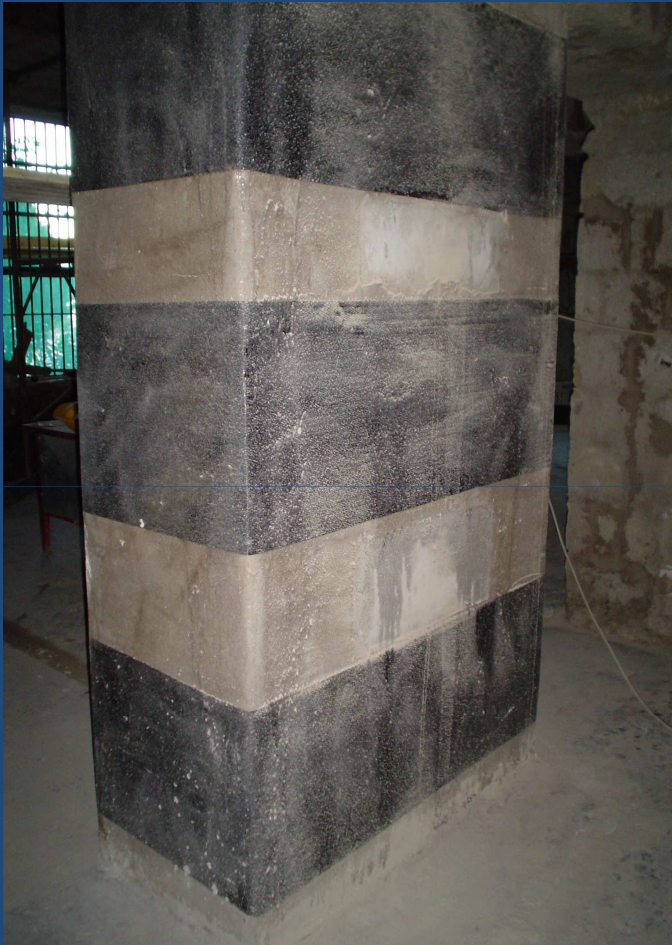
Le efficacissime cerchiature di colonne in fasce di tessuto al Carbonio
