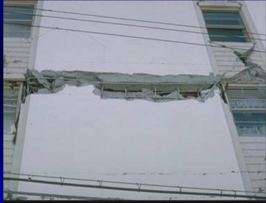
Figura 8.19. – Rottura giunto di collegamento
