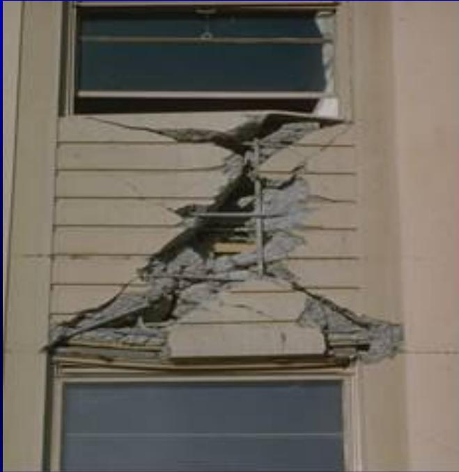
Rottura a taglio trasversi di collegamento
