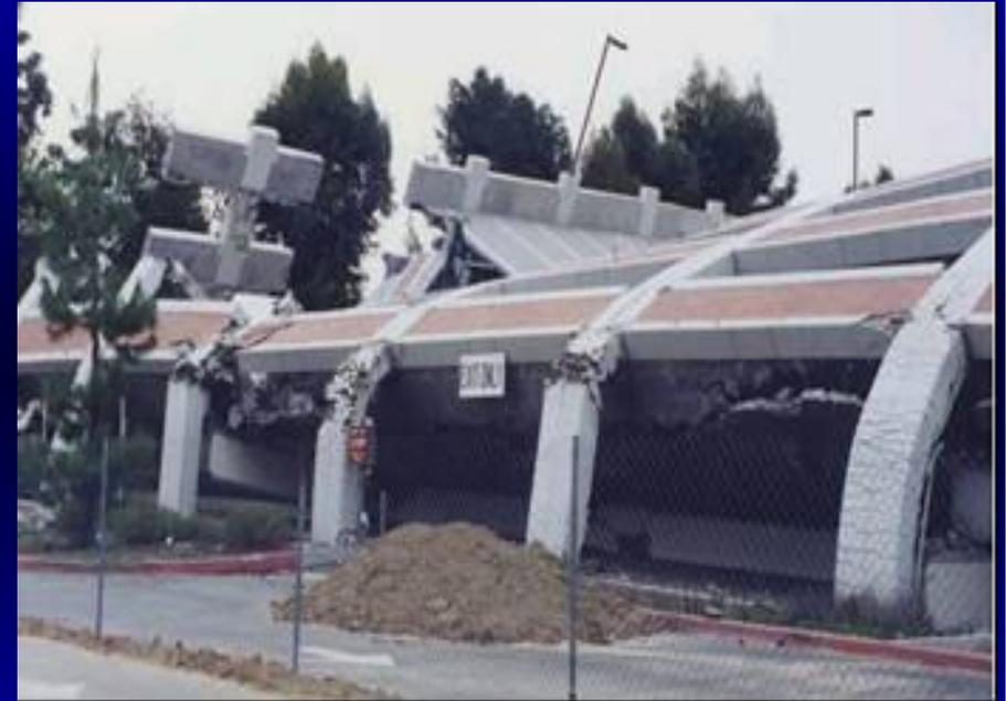
**Figura 8.13.** – Tipico collasso dovuto a ridotta iperstaticità (telai solo di perimetro).
