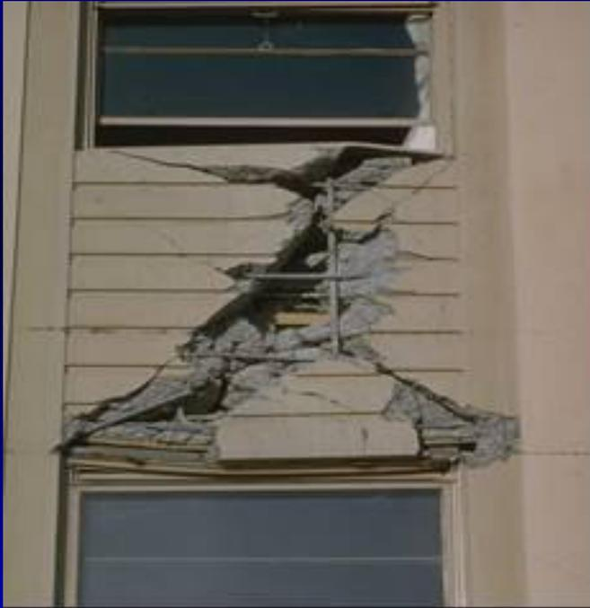
Figura 8.18. – Rottura per taglio
