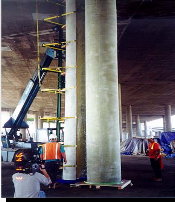
Confinamento: Fasciatura di colonne
