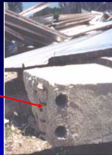
Figura 8.14. – Tipico collasso dovuto a collegamenti inadeguati.
