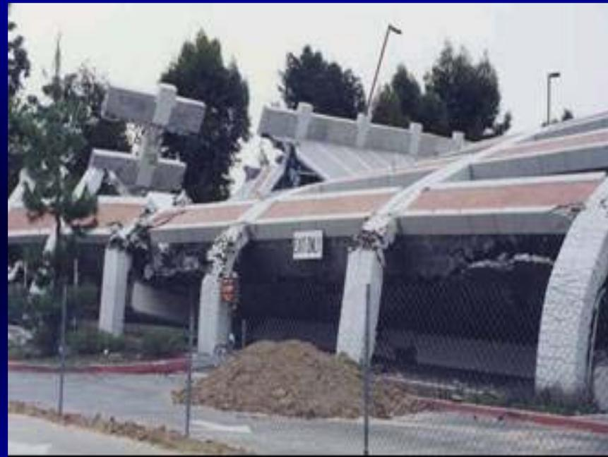
**Figura 8.13.** – Tipico collasso dovuto a ridotta iperstaticità (telai solo di perimetro).
