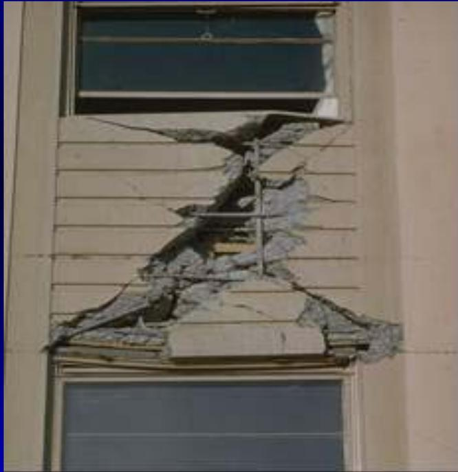
**Figura 8.18.** – Rottura per taglio
