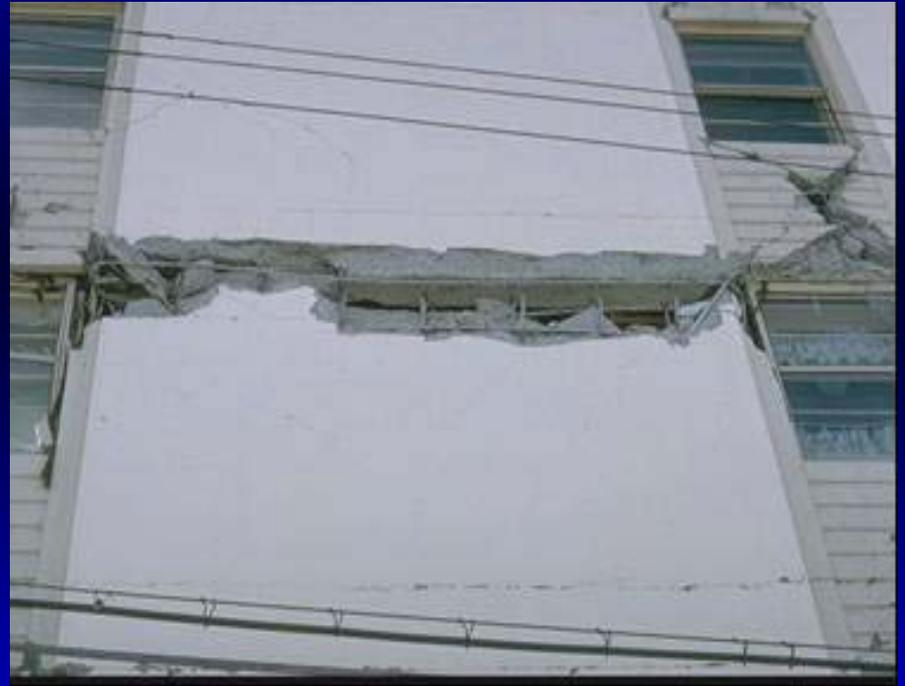
**Figura 8.19.** – Rottura giunto di collegamento
