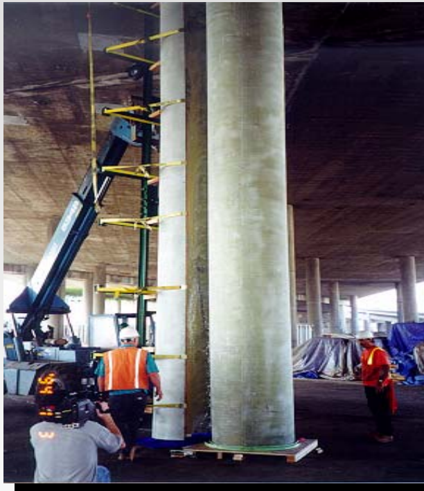
Confinamento: Fasciatura di colonne
