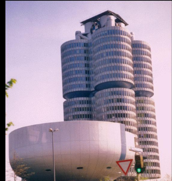
Struttura tube-in-tube (edificio BMW di Monaco)
