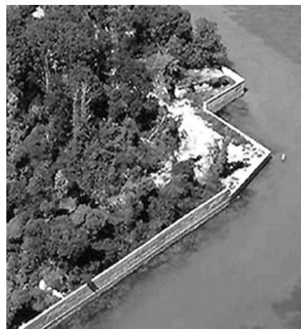
Fig. 3 - Muro di sponda
