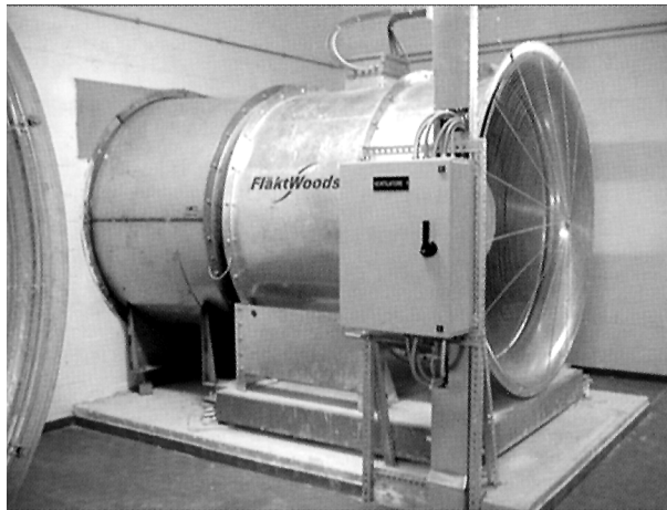
Un ventilatore Aerofoil JM totalmente reversibile/ adatto per funzionamento in emergenza incendio a 250°C per due ore
