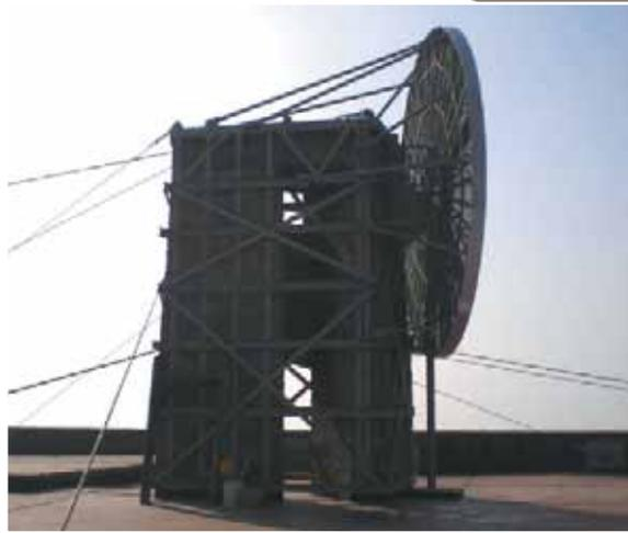
Fig. 4. Layout della soluzione adottata per la struttura di sostegno dell'opera d'arte.
