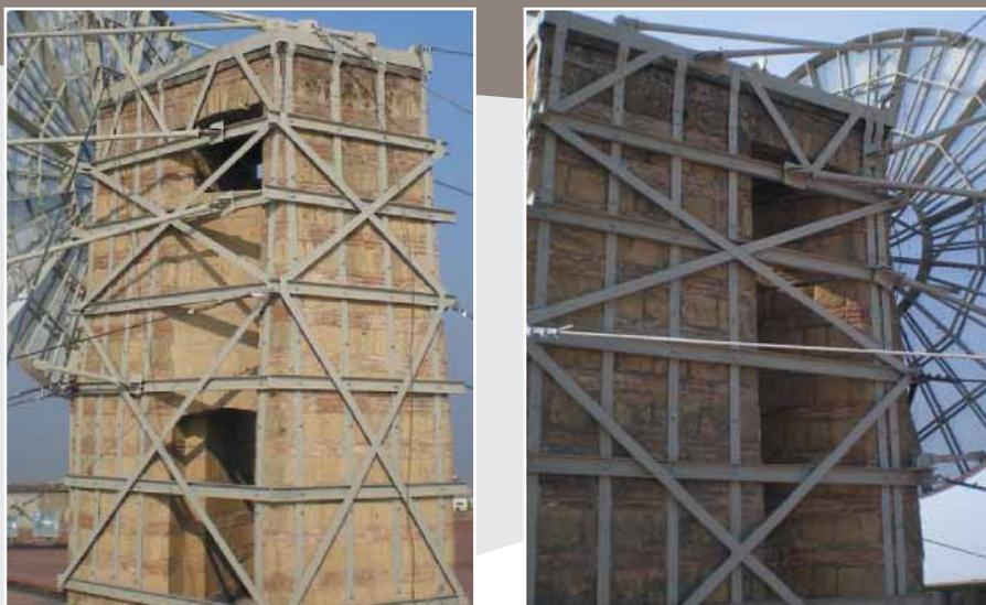
Fig. 9. Intelaiatura di acciaio di rinforzo per il torrino di muratura.
