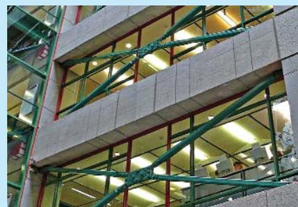
Figura 3. Controventi con dispositivi dotati di dissipatori attritivi.
