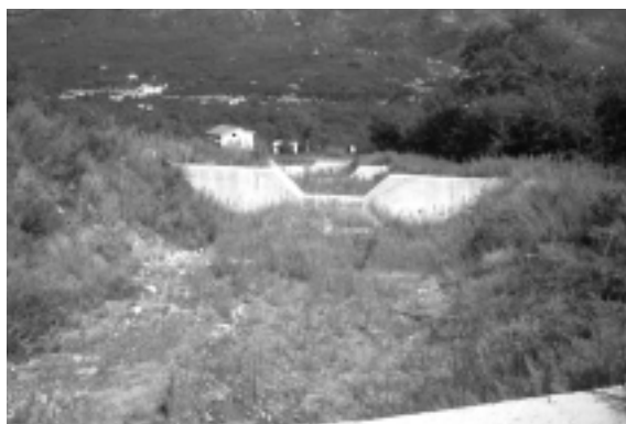
Fig 1 - Sistemazione con briglie chiuse (De Martino et al., 2002)
