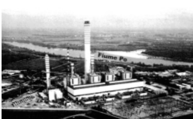
Carbonara Po (Mantova) Ciminiera alta 200 m
