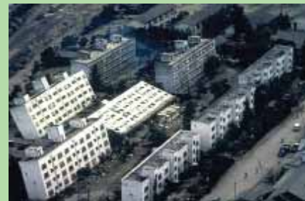
Figura 4. Effetto di sito (liquefazione): terremoto di Izmit (Turchia) del 17 agosto 1999.
