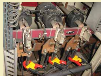
Figura 5. Inserimento dello strumento sull'impianto.
