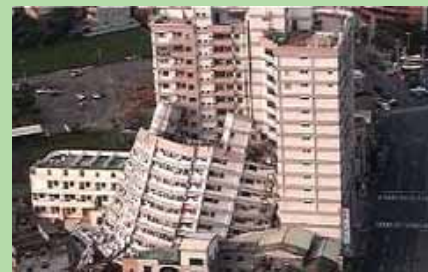
Figura 3. Effetto di sito (liquefazione): terremoto di Taichung (Taiwan) del 21 settembre 1999.
