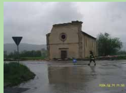
Figura 5. Esempio di collasso di una chiesa a Coppito in seguito alle scosse di replica.
