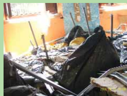
Figura 7. Scuola elementare Circolo Galilei (AQ), crollo di controsoffitti pesanti.
