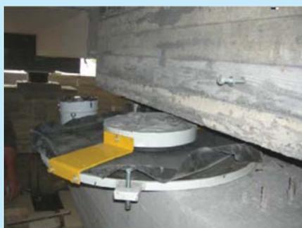
Figura 10. Isolatore FS in fase di montaggio.
