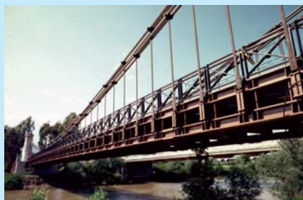
Figura 2. Il nuovo ponte "Real Ferdinando" sul Garigliano con luce di 80 m, dopo il restauro strutturale.
