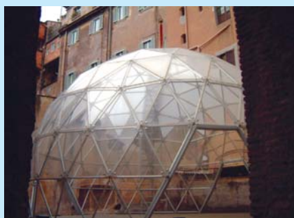
Figura 3. La cupola geodetica all'interno del Museo dei Mercati Traianei a Roma realizzata con il sistema asta-nodo tipo Geo-system.
