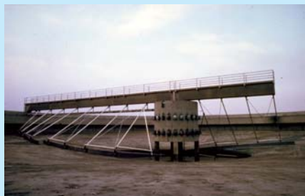
Figura 1. Uno degli otto carroporti rotanti dell'impianto di depurazione Po-Sangone a Torino.
