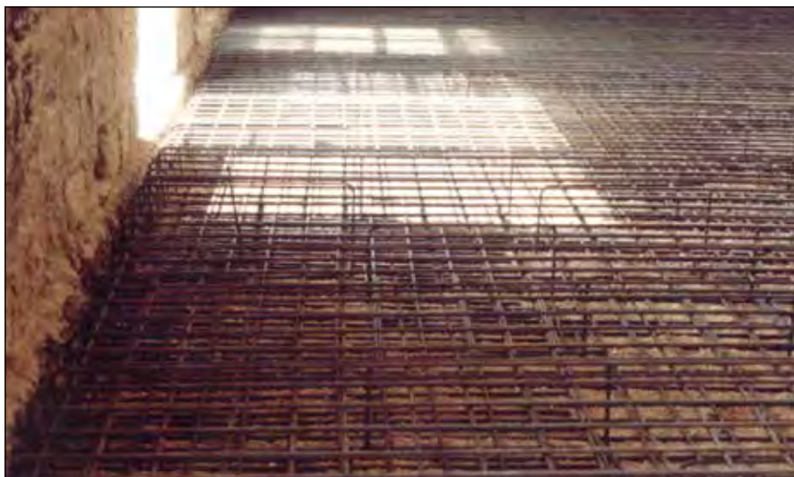
Figura 5-6. Realizzazione zattera in un edificio in cemento armato.
