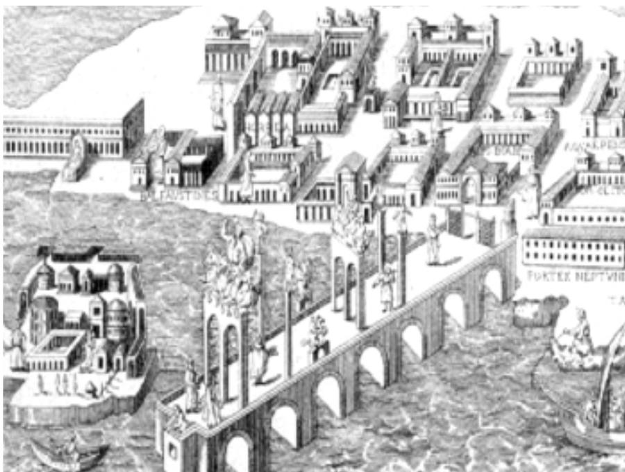
Figura 1- Il porto di Puteoli (disegno Bellori, 1764) costituisce un esempio di opera di protezione a parete forata (opus pilarum) che consente la circolazione detritica
