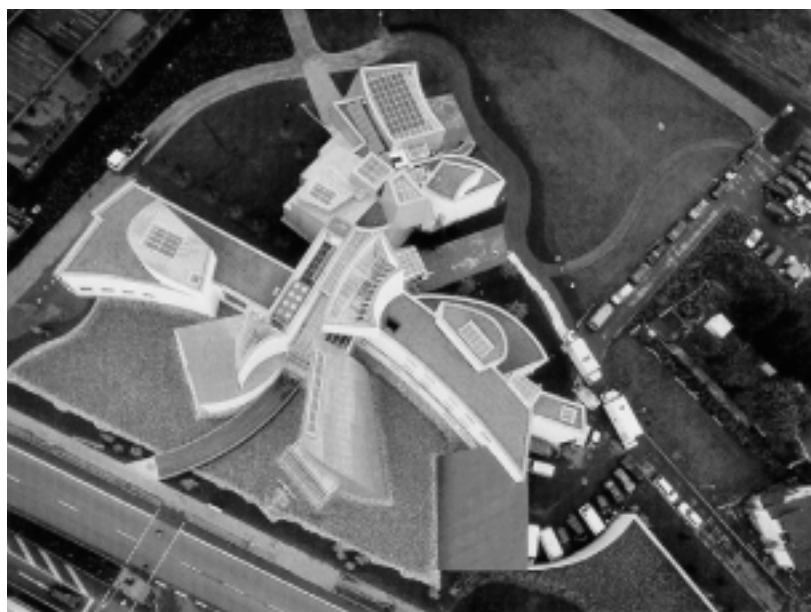
Frank Gehry, Energy Forum Innovation, Bad Oeyenhausen, Germania Superficie fotovoltaica: 54 mq Potenza dell'impianto: 2 kWp Rendimento: 1.200 kWp annui
