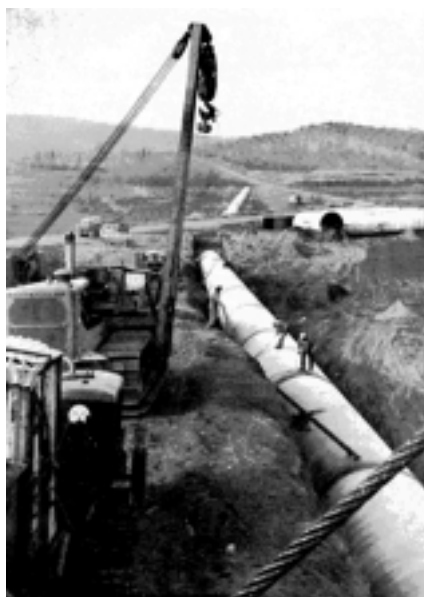
Acquedotto del Sinni - Posa di tubazione in acciaio DN 3000 mm
