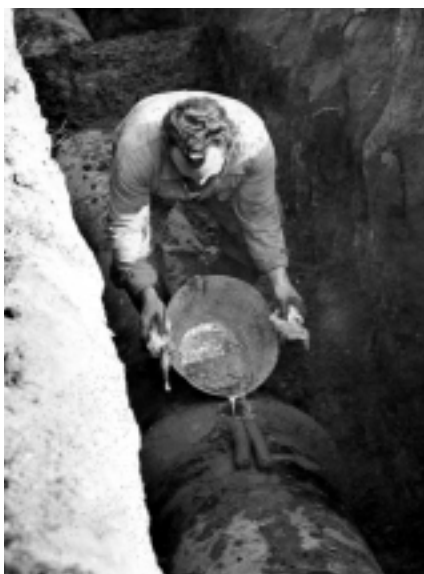
Acquedotto consortile di Terra di Lavoro (1953) - Giunto in piombo su condotta in ghisa del DN 600mm
