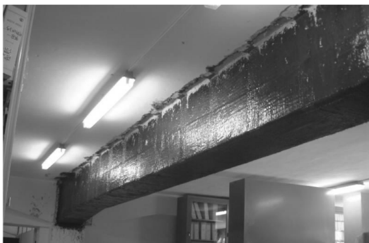
Figura 10: Applicazione di tessuti e fasce in fibra di carbonio alla trave lesionata.
