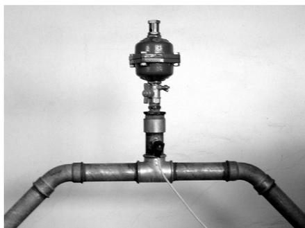
Fig. 3. Sifone posto lungo il tracciato con dispositivo di sfiato (sfiato automatico modello VENTOLO).
