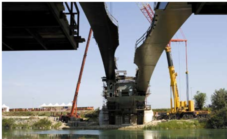
Fig. 22: le travi della campata centrale in posizione di varo
