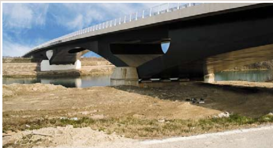
Fig. 25 : la campata centrale dopo l'eliminazione dei sostegni provvisori
