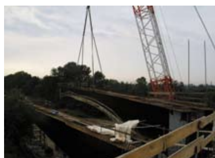
Fig. 15: sollevamento della prima trave della campata centrale dalla centina provvisoria
