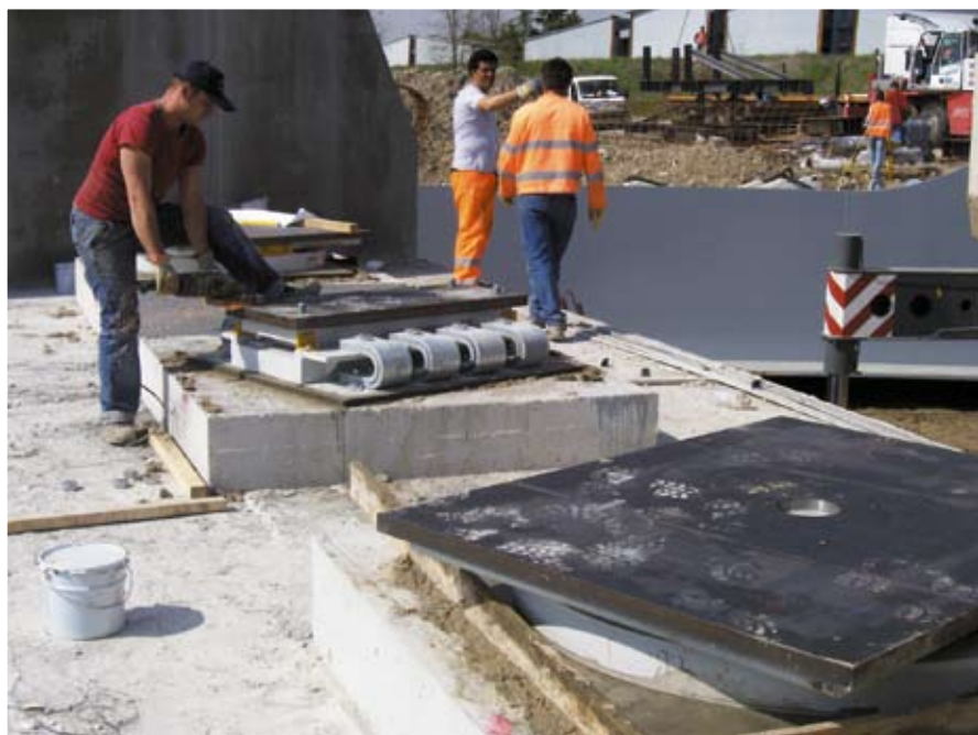
Fig. 13: appoggi della pila 3, al centro i sistemi di smorzamento
