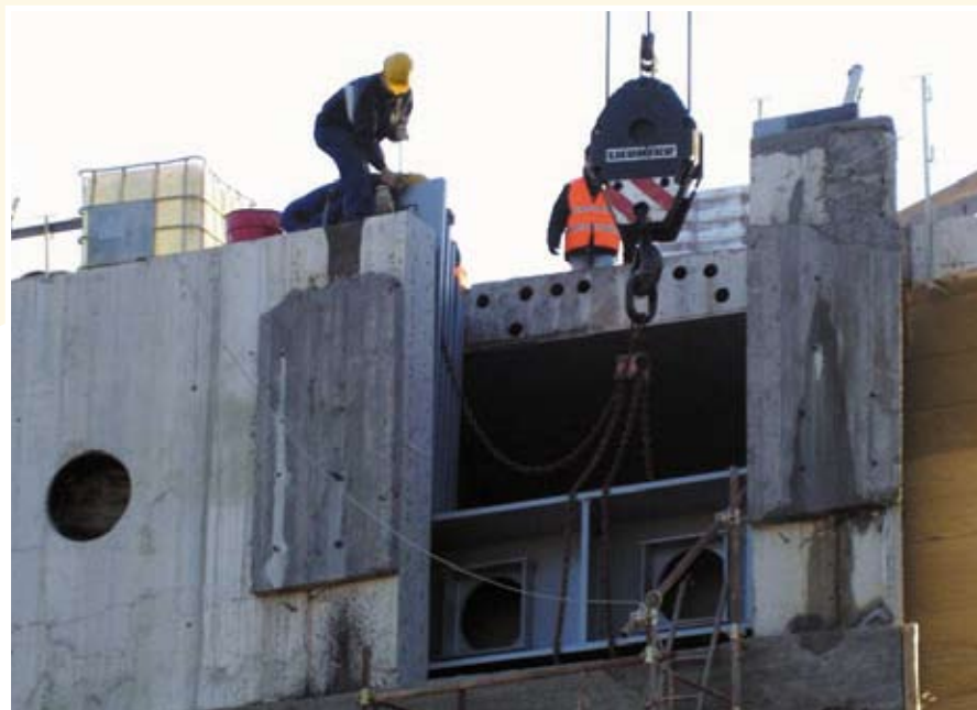
Fig. 11: sella di transizione inserita nella pila 4
