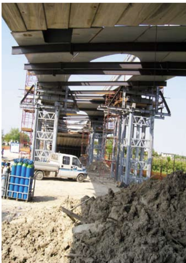
Fig. 9: vista dell'intradosso della campata di riva in sx Piave durante il montaggio della carpenteria metallica
