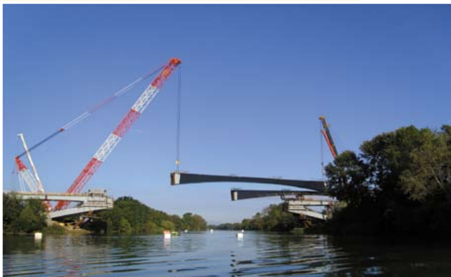
Fig. 18: sollevamento della prima trave della campata centrale dalla centina provvisoria
