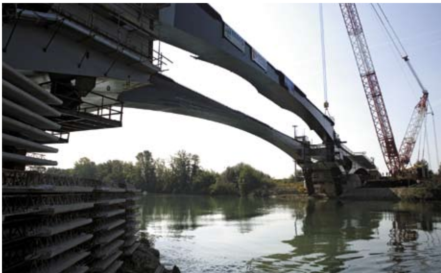
Fig. 21: le travi della campata centrale in posizione di varo
