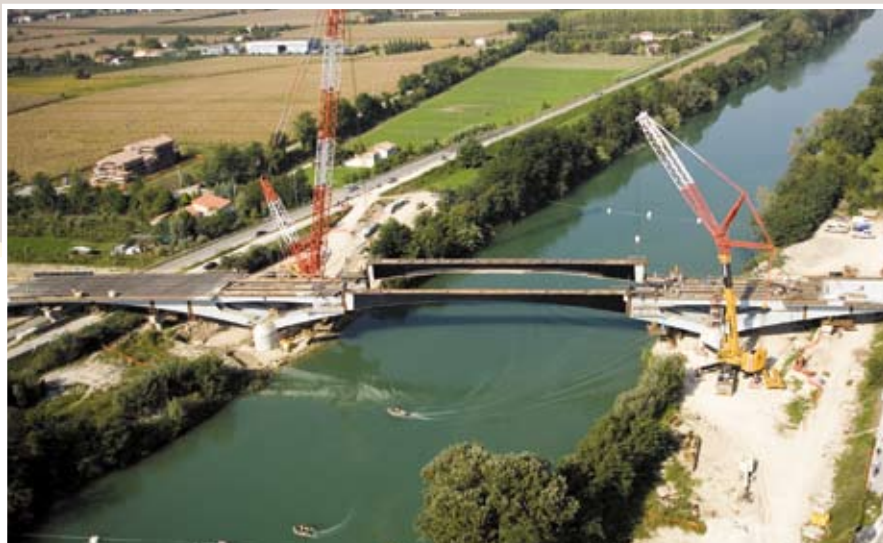
Fig. 20: le travi della campata centrale in posizione di varo
