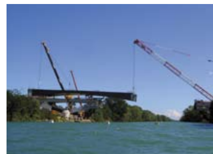
Fig. 17: le travi della campata centrale in posizione di varo
