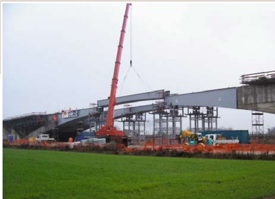
Fig. 14: varo dal basso del concio centrale di campata 5
