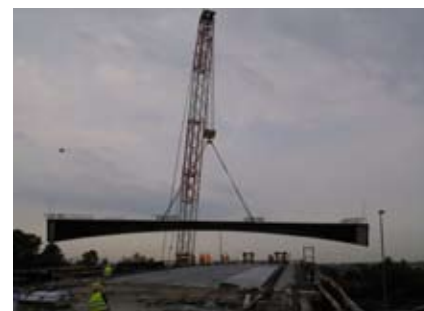
Fig. 16: collocazione in posizione di varo
