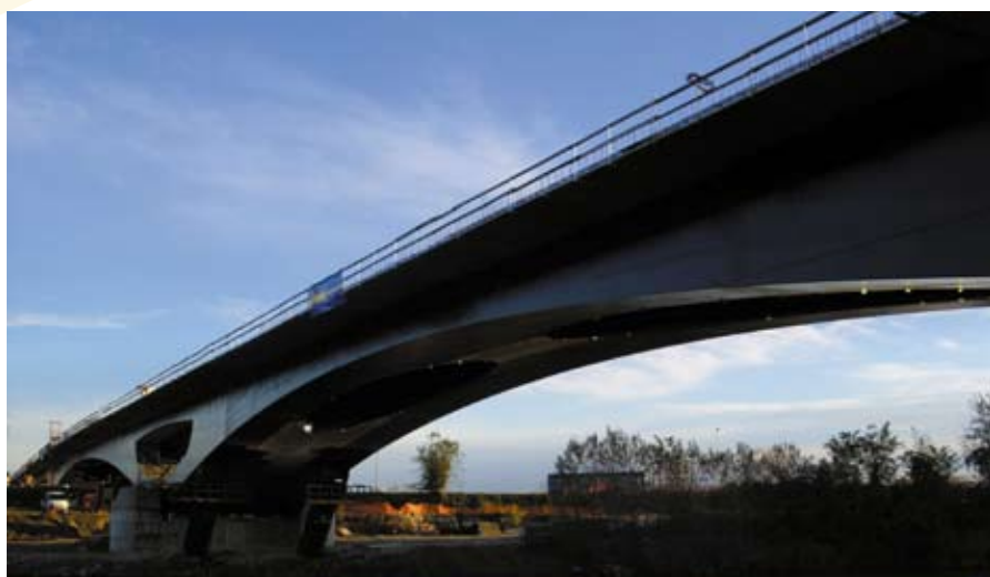
Fig. 23 : la campata centrale dopo l'eliminazione dei sostegni provvisori
