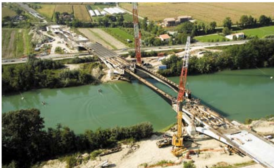
Fig. 19: collocazione in posizione di varo
