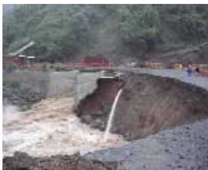
Erosione alla diga di protezione.
