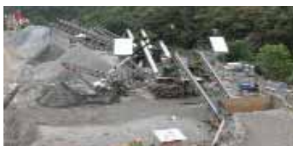
Impianto di frantumazione secondaria-terziaria-quaternaria.
