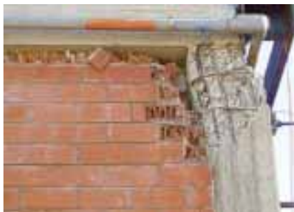
Figura 15. Crisi per taglio del pilastro dovuta all'interazione con la tamponatura.
