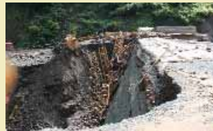
Danni ad attrezzature portate in diga (struttura gru di monte).
