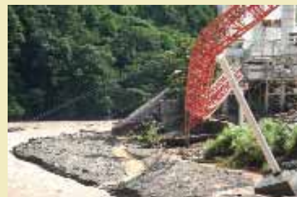
Cedimento della fondazione del pilone.
