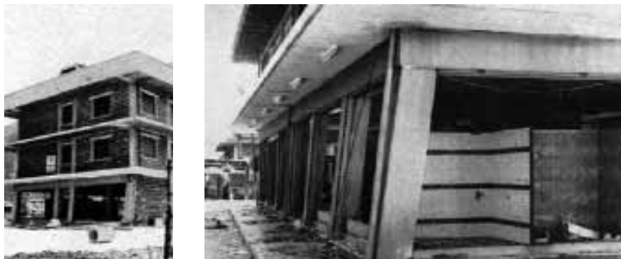
Figura 17. Effetti torsionali dovuti a distribuzioni irregolari in pianta delle tamponature.
