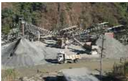
Impianto di frantumazione secondaria-terziaria-quaternaria.
