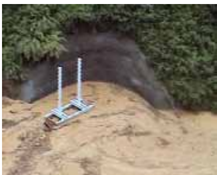
Entrata del tunnel di deviazione.
