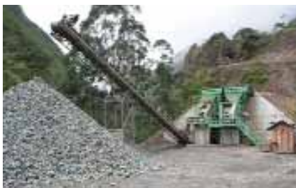
Impianto di frantumazione primaria.
