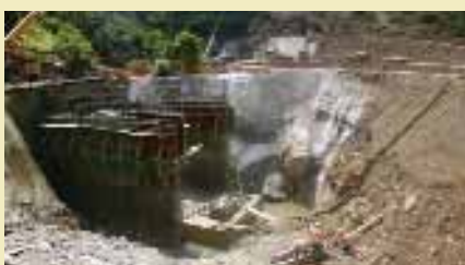
Struttura di uscita del tunnel di deviazione.
