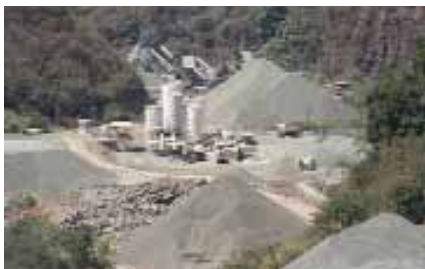
Impianto CON-E-CO con vista di alcuni stock di aggregati.
