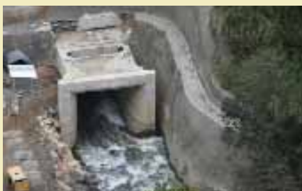
Struttura di ingresso del tunnel di deviazione.
