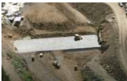
Diga di incanalamento del fiume nel tunnel di deviazione.
