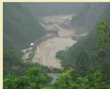
Vie interne e diga inondate, diga di protezione crollata.
