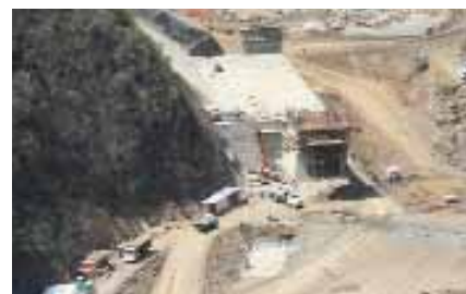
Tunnel e canale dello scarico di fondo.
