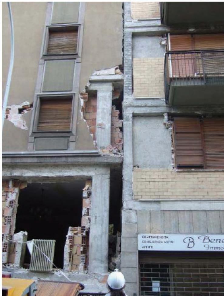
Figura 13. Danneggiamento in via XX Settembre, a L'Aquila, per inadeguatezza del giunto sismico.
