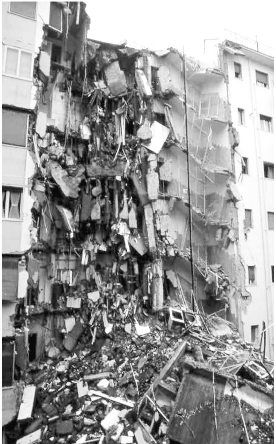
Il crollo al Rione Arenella
