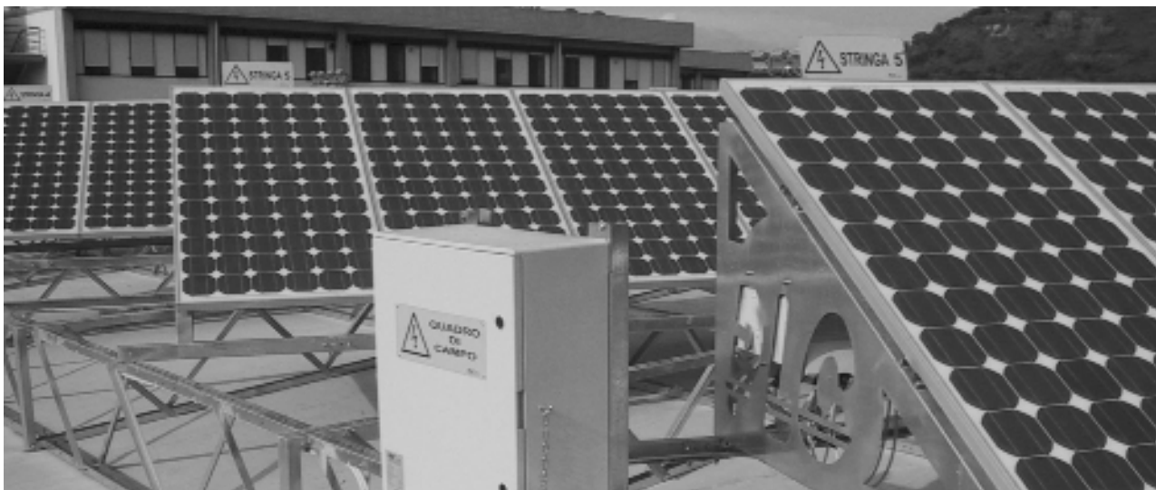
I pannelli fotovoltaici installati presso il CUS di Napoli
