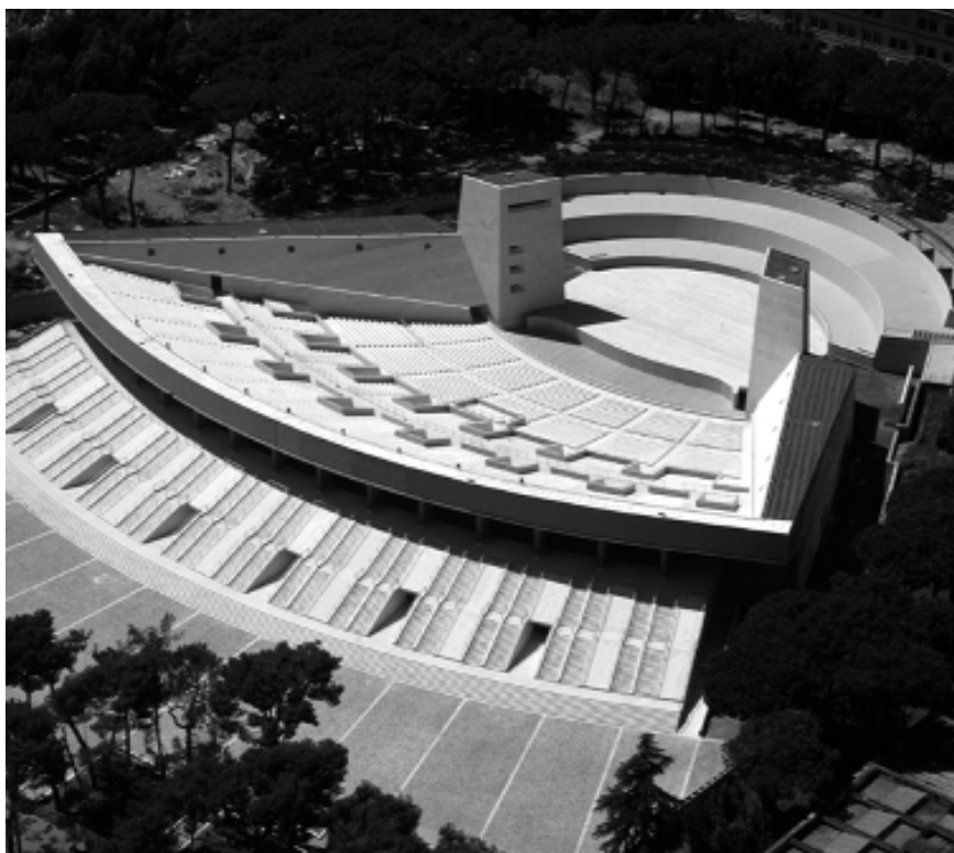
Panoramica dell'Arena Flegrea
