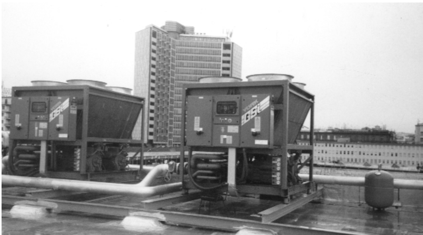
Napoli vive un momento di notevole sviluppo degli impianti di condizionamento, grazie all'impiego di gruppi refrigeratori d'acqua con condensatori raffreddati ad aria. Nella foto: gruppi frigoriferi che alimentano gli uffici FS di Napoli Centrale
