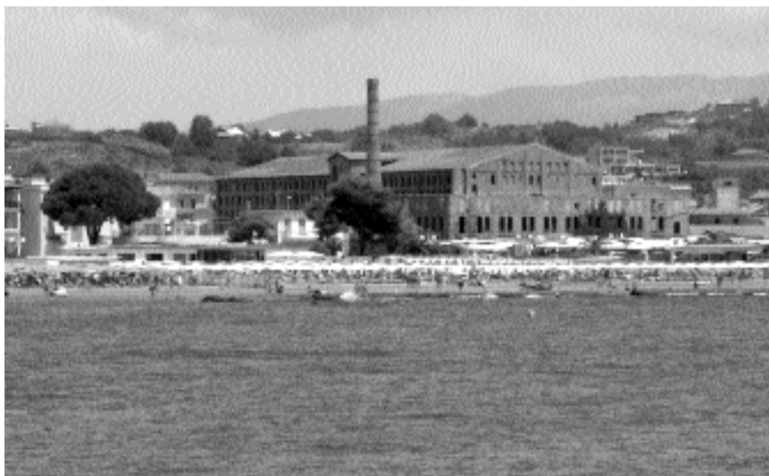
Fig. 1 - Vista dal mare della fornace
