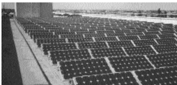
Fig. 3 Programma Nazionale "Tetti Fotovoltaici" - Edificio in Via Don Miraglio - Mantova (fonte: MINISTERO DELL'AMBIENTE E DELLA TUTELA DEL TERRITORIO)
