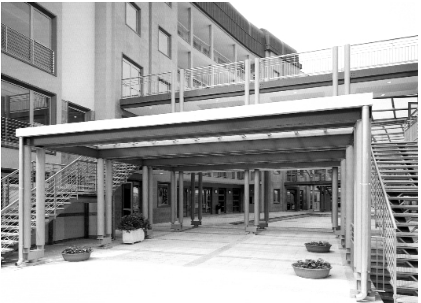
Una veduta delle scale di sicurezza del complesso universitario
