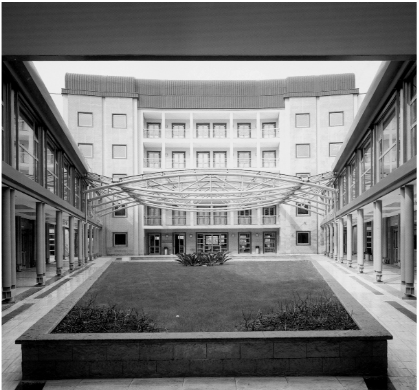
Un aspetto del patio della nuova sede distaccata della facoltà di ingegneria "Federico II" di Napoli
