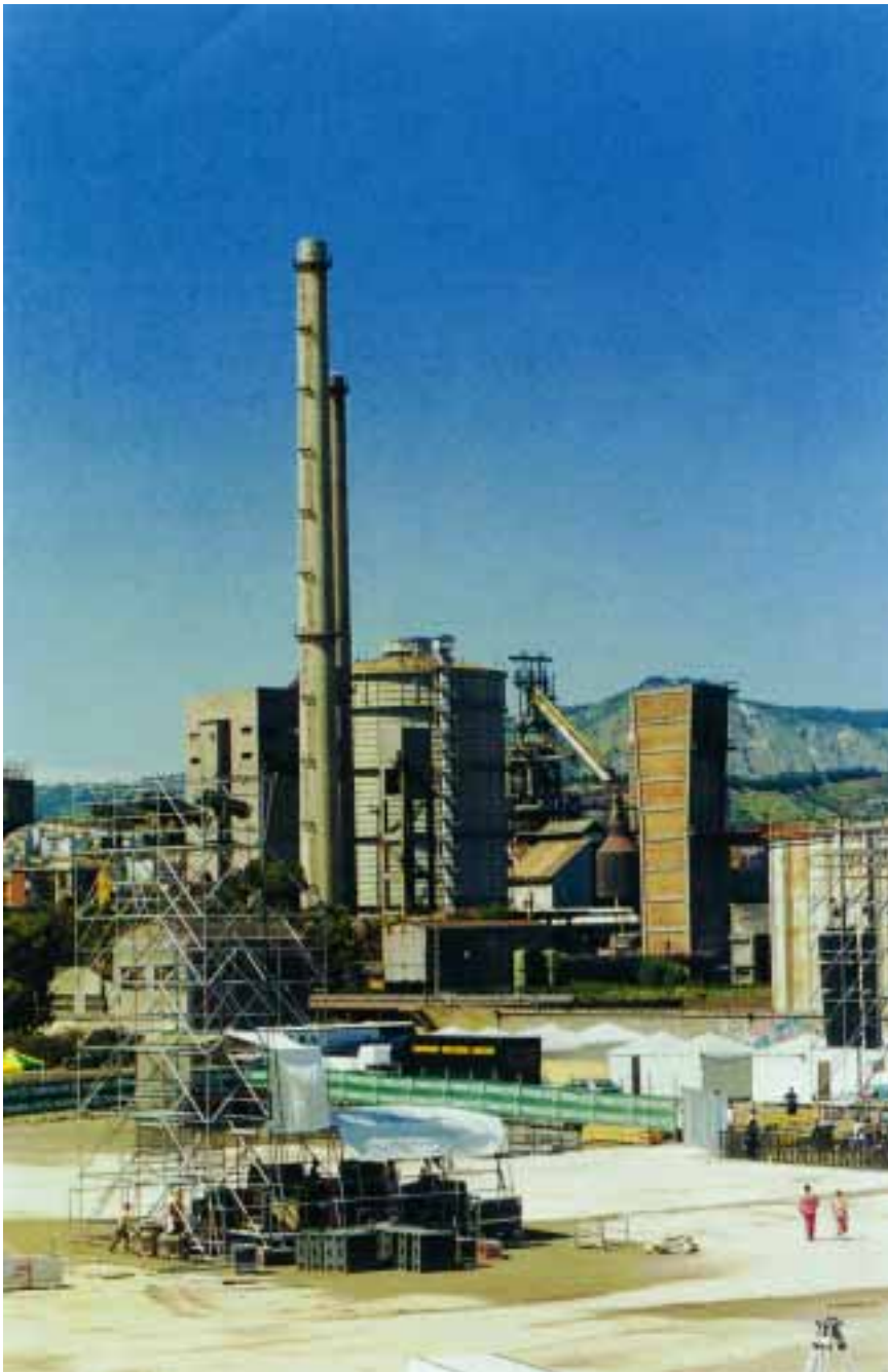
Stabilimenti ex Italsider.
