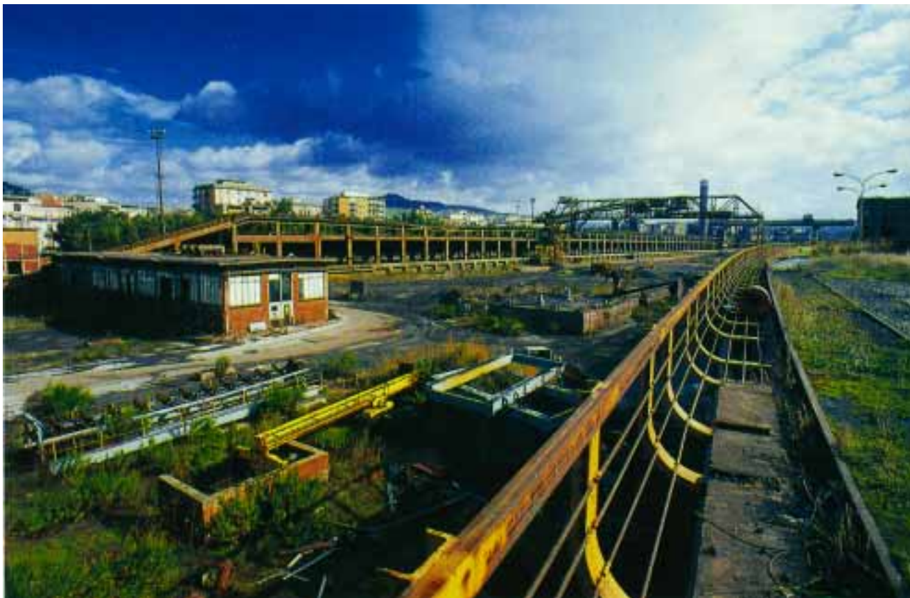
L'area del deposito minerali con il carro ponte.
